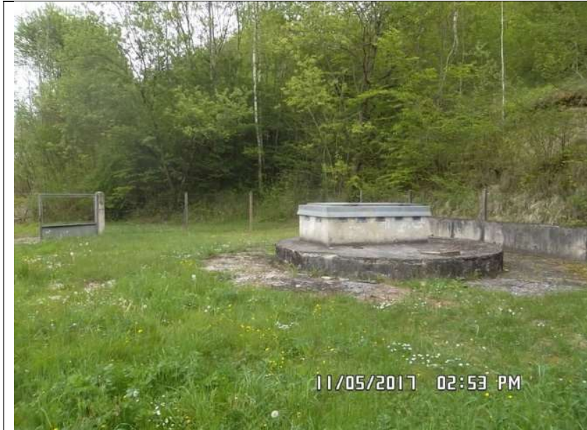
Vue externe de la chambre de captage
